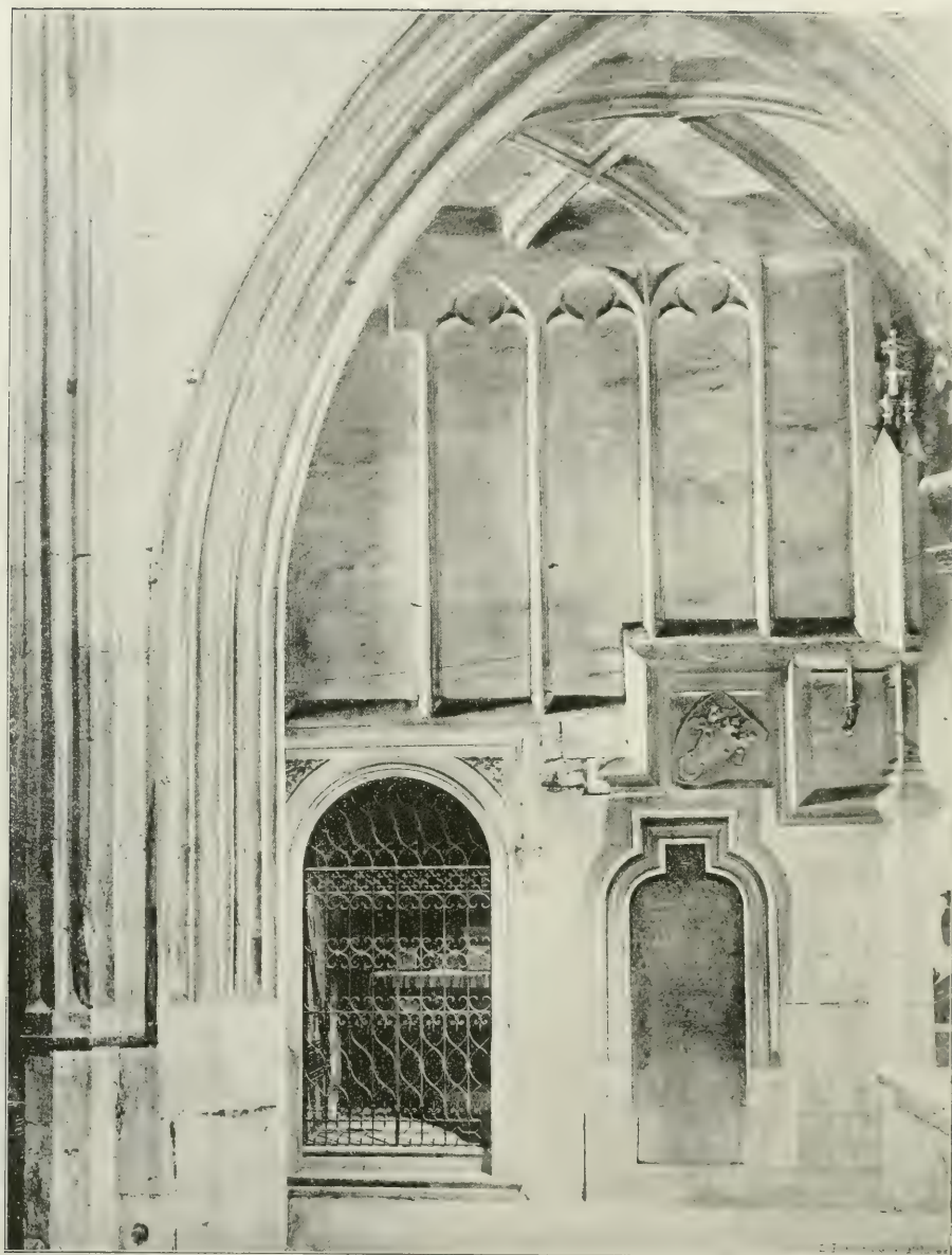
Fig. 31. Sciana wieży w nawie bocznej kościoła.
